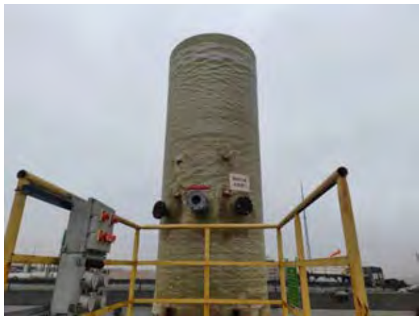
DA030 采样平台、采样口及环保标识
