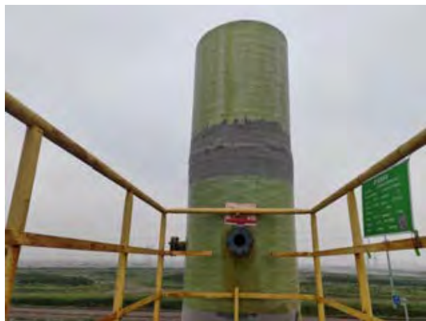
DA008 采样平台、采样口及环保标识
