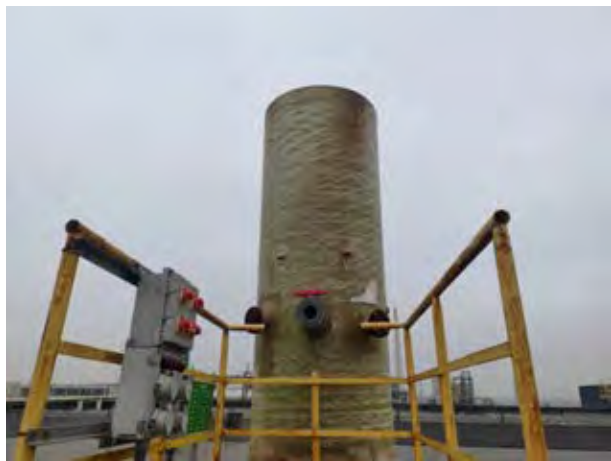
DA009 采样平台、采样口及环保标识
