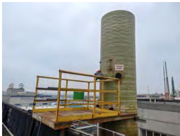
DA010 采样平台、采样口及环保标识
