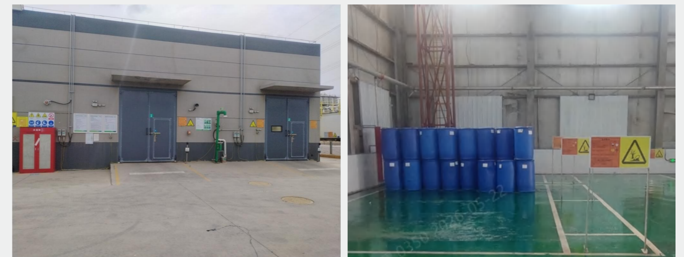
危险废物仓库及内部分区
