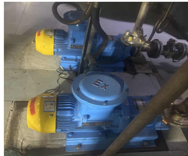
宁夏北厂区投资15.7万元，对三酮车间易泄漏的IH易泄漏的单面离心泵改为磁力泵，有效降低车间动设备密封点泄漏量，改善车间整体环境。
