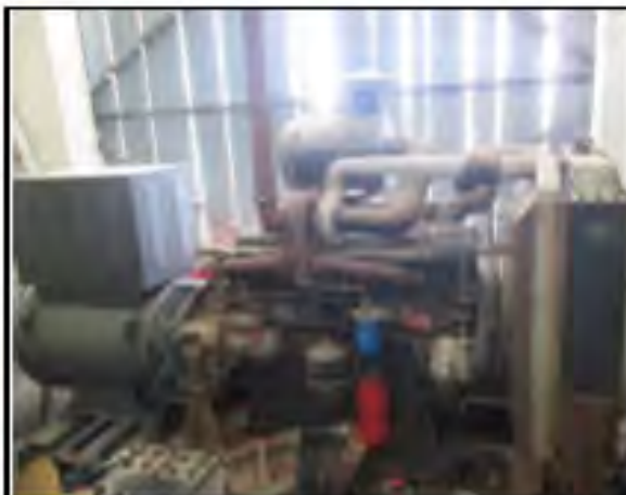
柴油发电机组(应急备用电源)
