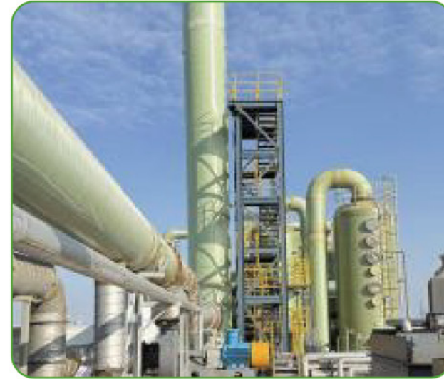
B线、实验楼更改取样口、新建取样平台。
