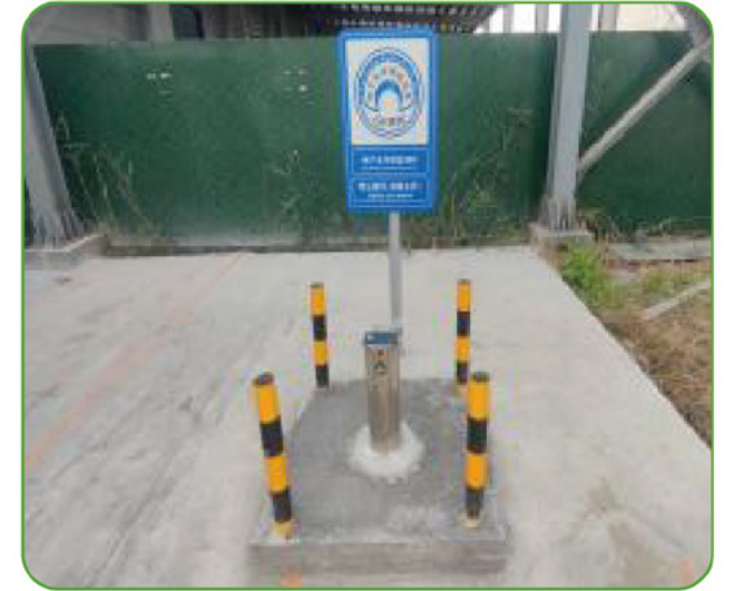
公司为保证地下水质量，新挖2口地下水监测井。
